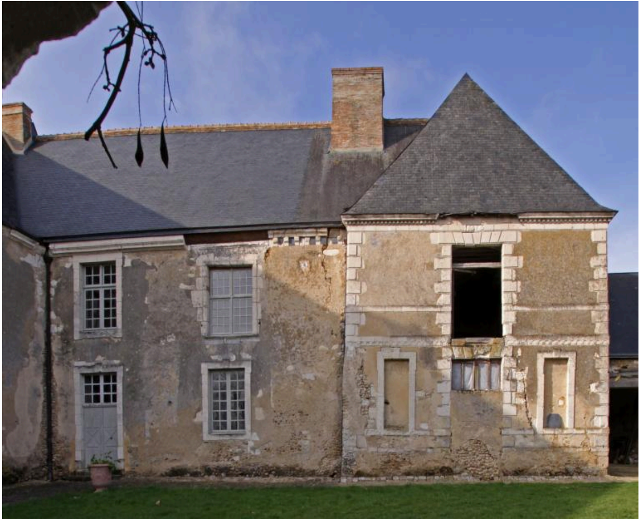
Corps de logis central et pavillon XVIIIe, façades sur cour.
