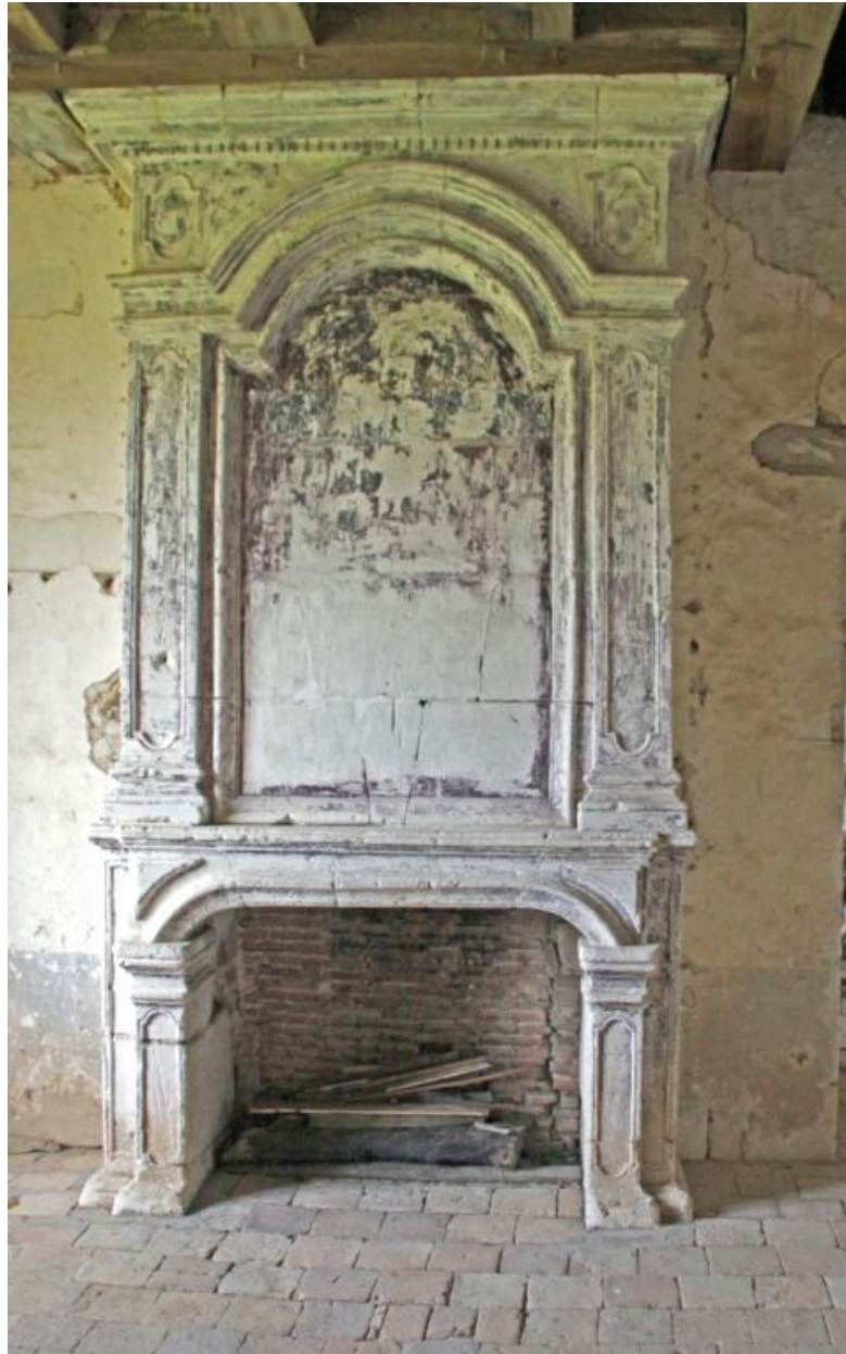
Pavillon, étage côté jardin, salle à feu : cheminée.
