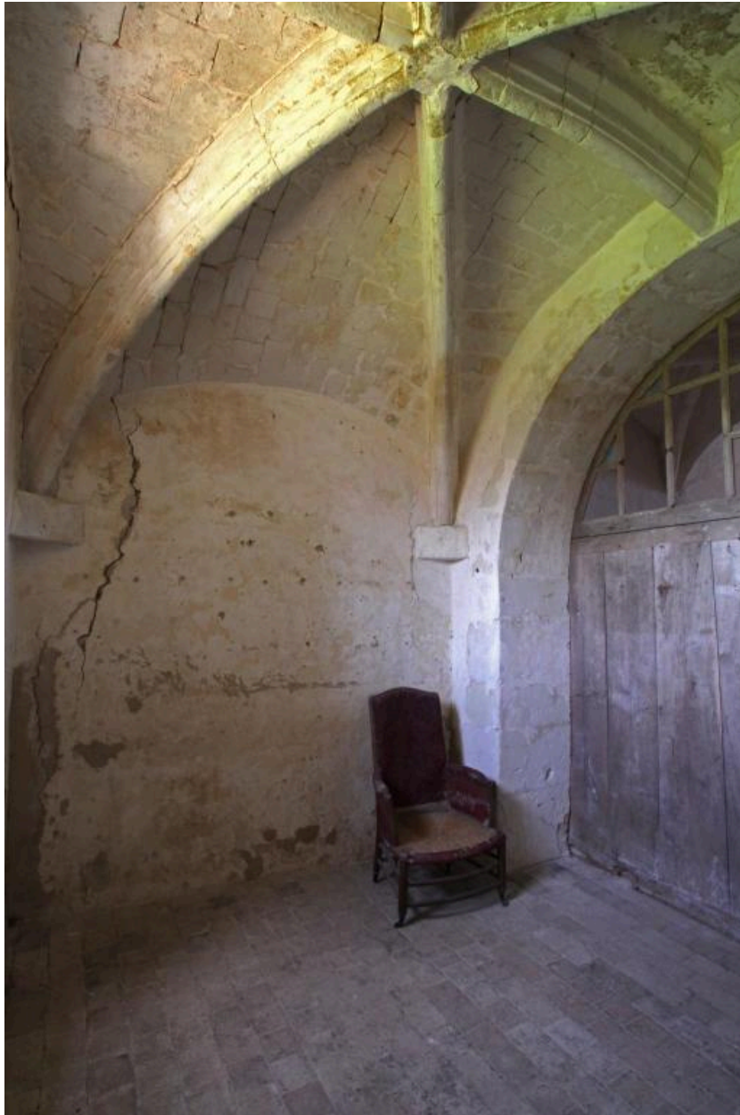
Corps central, côté cour, entresol : chapelle.
