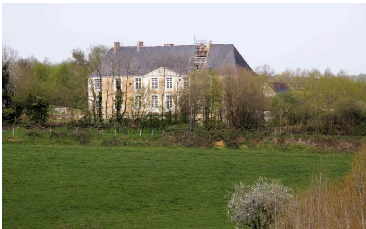
Vue d'ensemble prise depuis le sud-est.
