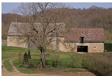
Grange et étable. Phot. Jean-Baptiste Darrasse IVR52_20107200428NUCA
