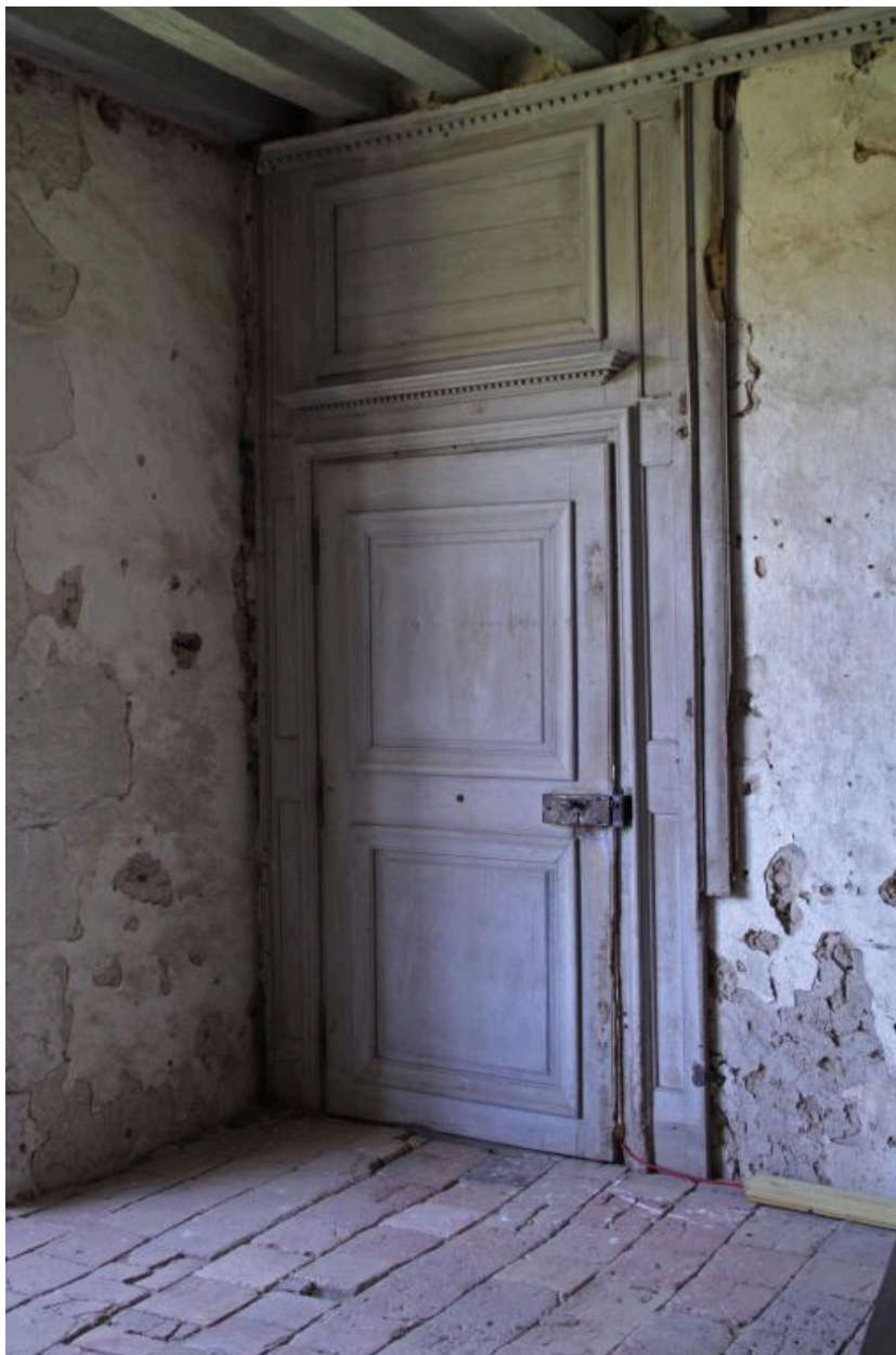
Corps central, étage : palier et porte ouvrant sur l'aile XVIIIe.
