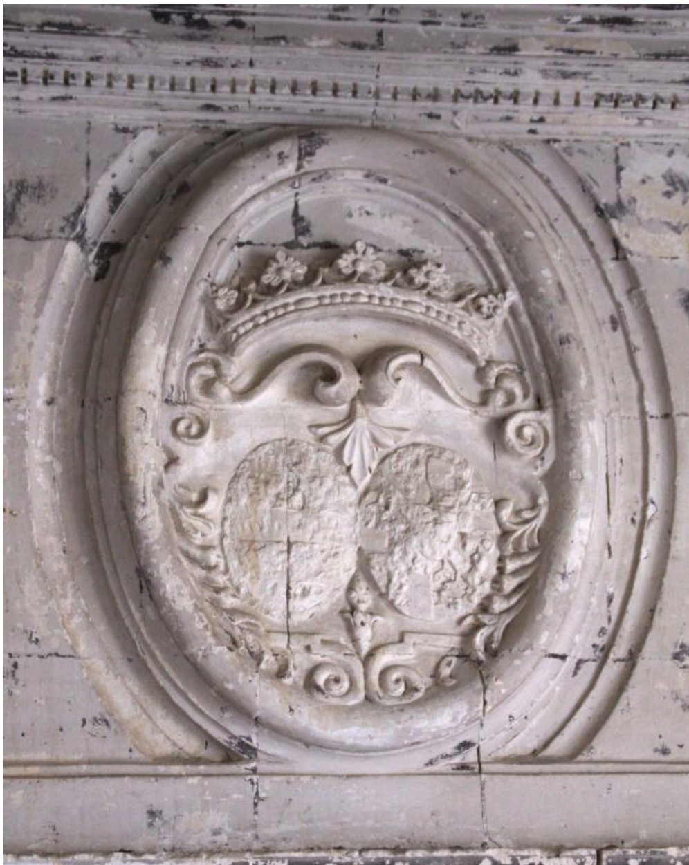
Corps central, étage côté cour, grande salle : détail du médaillon (avec couronne de marquis) sur la hotte de la cheminée.
