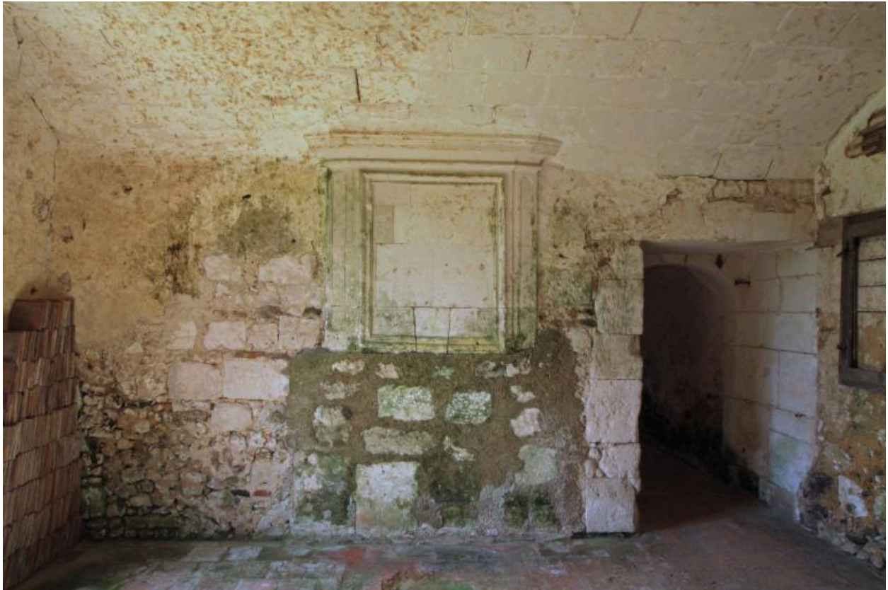
Pavillon, r-d-c côté jardin : pièce voûtée (sud).
