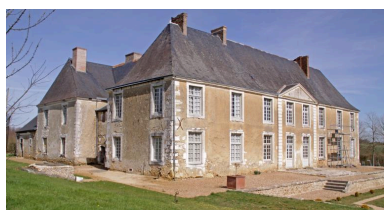
Vue de volume prise depuis le sud. Phot. Jean-Baptiste Darrasse IVR52_20107200426NUCA
