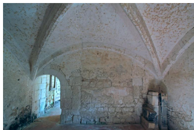
Pavillon, rez-de-chaussée côté jardin : pièce voûtée en ogive (nord). Phot. Jean-Baptiste Darrasse IVR52_20107200432NUCA
