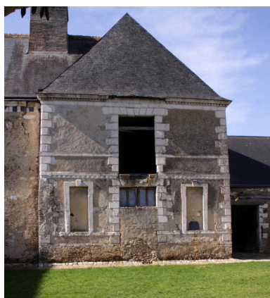
Pavillon XVIIe, façade sur cour. Phot. Jean-Baptiste Darrasse IVR52_20107200407NUCA
