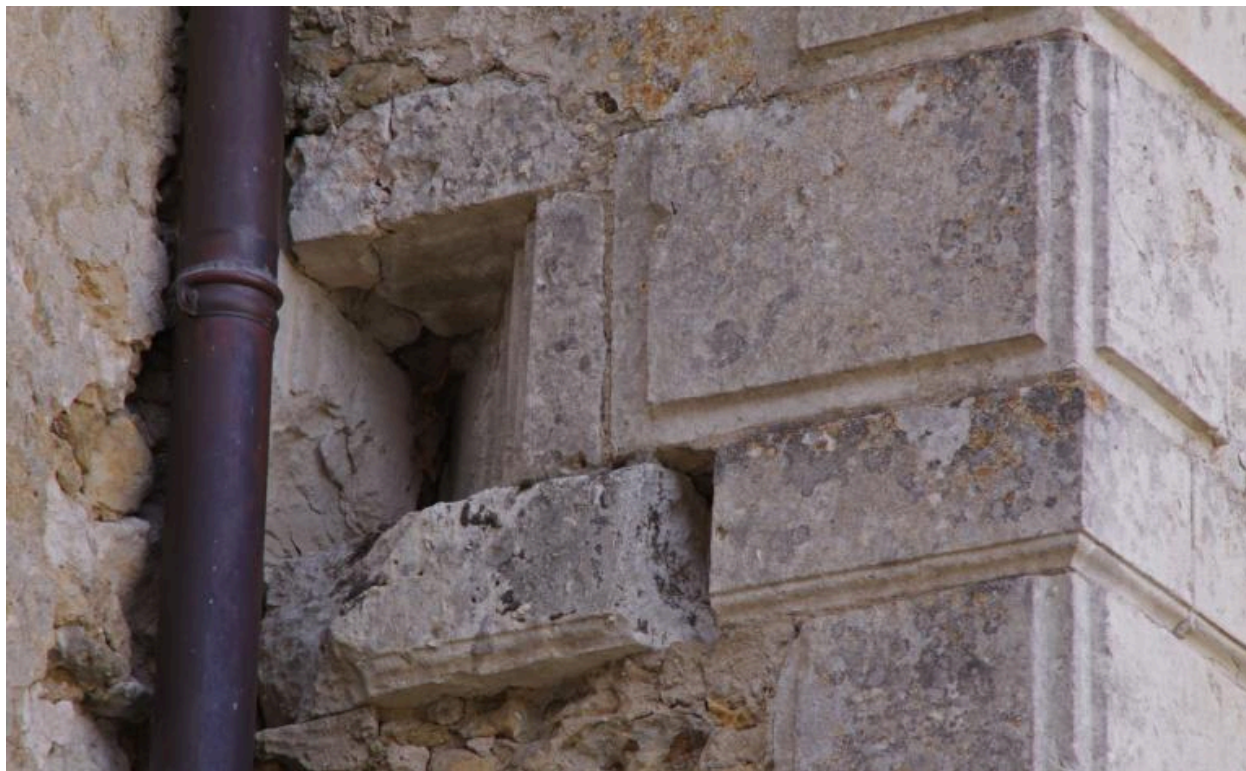
Pavillon, façade sur cour : bouche-à-feu ouverte en direction de la porte d'entrée du corps central.
