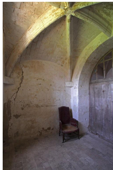
Corps central, côté cour, entresol : chapelle. Phot. Jean-Baptiste Darrasse IVR52_20107200412NUCA
