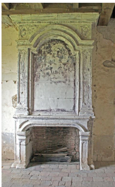
Pavillon, étage côté jardin, salle à feu : cheminée. Phot. Jean-Baptiste Darrasse IVR52_20107200421NUCA
