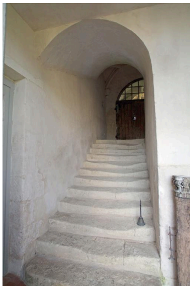
Corps central : volée d'escalier conduisant du rez-de-chaussée (côté cour) à l'entresol où est la chapelle. Phot. Jean-Baptiste Darrasse IVR52_20107200422NUCA
