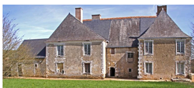
Façades sud-ouest. Phot. Jean-Baptiste Darrasse IVR52_20107200425NUCA
