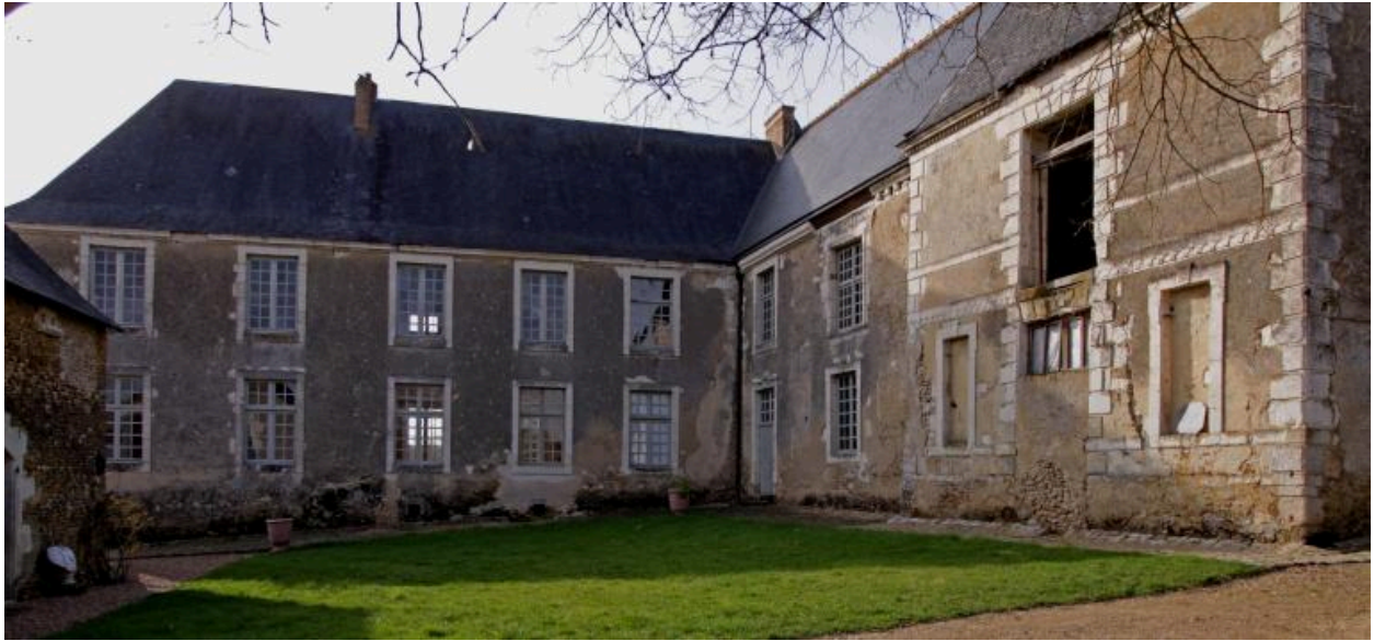
Façades sur cour.
