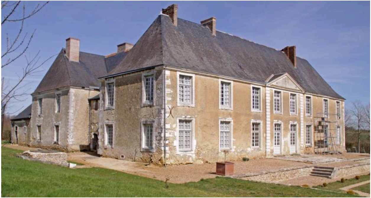
Vue de volume prise depuis le sud.
