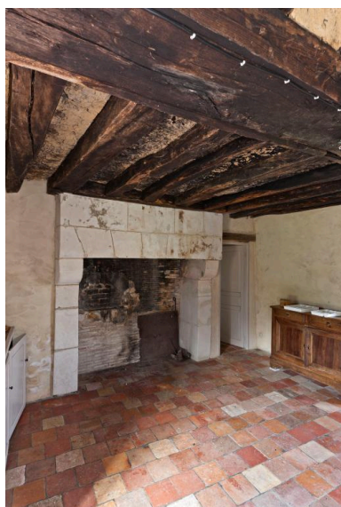
Dépendance 2, RdCh, pièce à feu : cheminée. Phot. Yves Guillotin IVR52_20127200168NUCA
