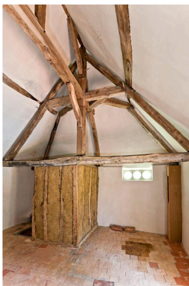
Dépendance 2, étage sous comble : détail de la charpente. Phot. Yves Guillotin IVR52_20127200169NUCA
