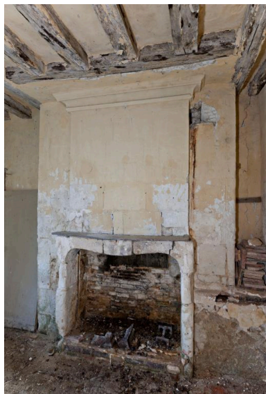
Dépendance 1, RdCh, pièce à feu : cheminée. Phot. Yves Guillotin IVR52_20127200256NUCA
