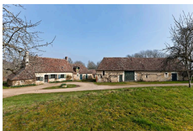
Ferme située au nord du château. Phot. Yves Guillotin IVR52_20127200170NUCA
