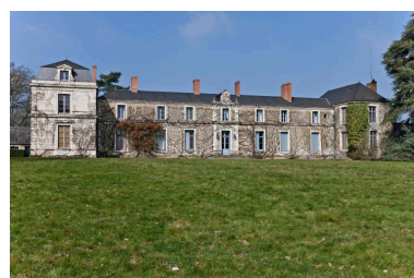
Château : façade sud-est sur parc. Phot. Yves Guillotin IVR52_20127200179NUCA
