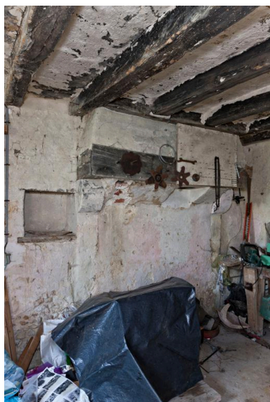
Communs, RdCh, pièce à feu : cheminée. Phot. Yves Guillotin IVR52_20127200177NUCA
