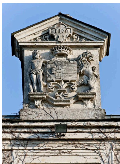
Château, façade du corps central sur cour : édicule sommital aux armes de la famille de la Porte aux loups. Date portée : 1870.
