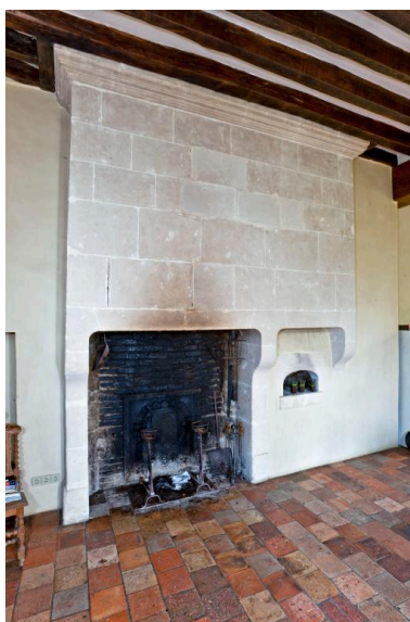
Château, aile sud-ouest, RdCh : cheminée et potager.
