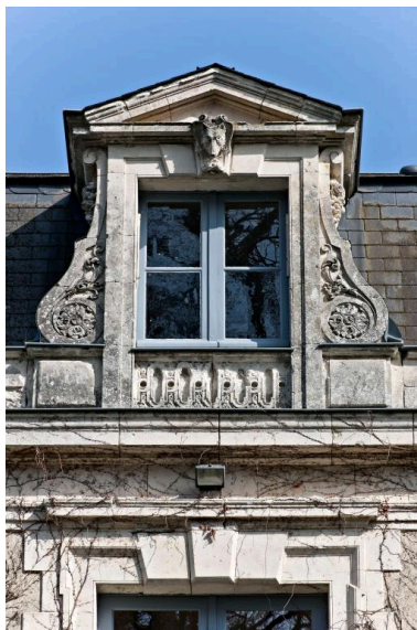
Château, aile sud-ouest, façade principale : lucarne du comble. Phot. Yves Guillotin IVR52_20127200183NUCA
