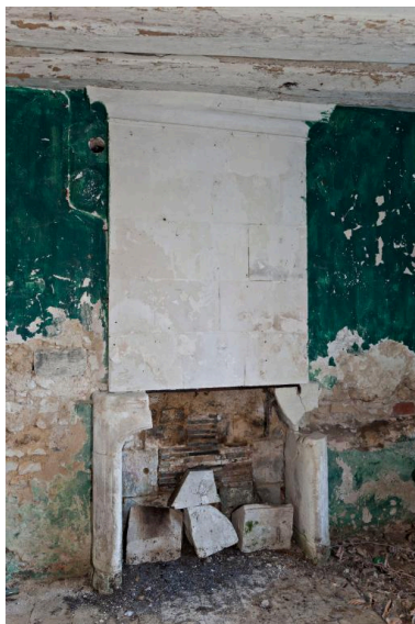
Dépendance 1, RdCh, autre pièce à feu : cheminée. Phot. Yves Guillotin IVR52_20127200257NUCA
