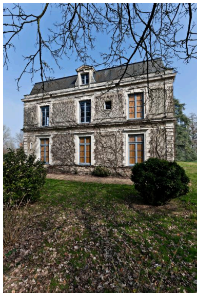
Château, aile sud-ouest : façade principale. Phot. Yves Guillotin IVR52_20127200182NUCA
