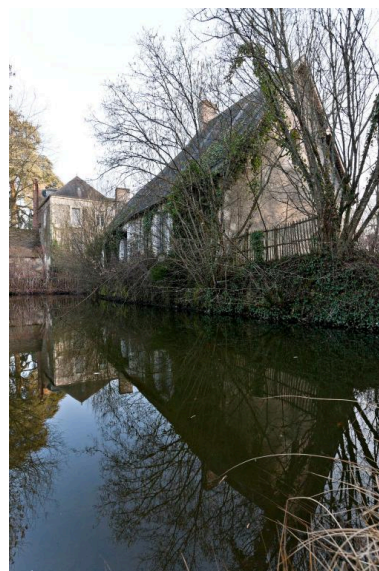
Douve à l'arrière de la dépendance 1. Phot. Yves Guillotin IVR52_20127200261NUCA
