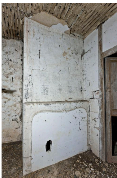
Dépendance 1, comble : cheminée. Phot. Yves Guillotin IVR52_20127200258NUCA
